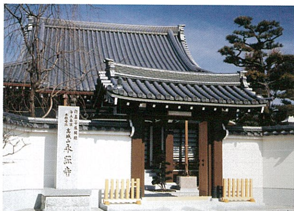
阪神淡路大震災後、復興された本堂 山門
