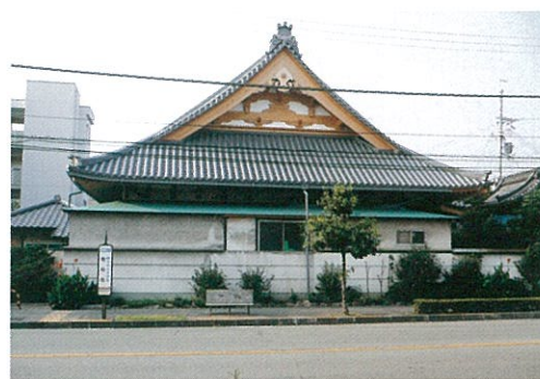
本堂南側より
